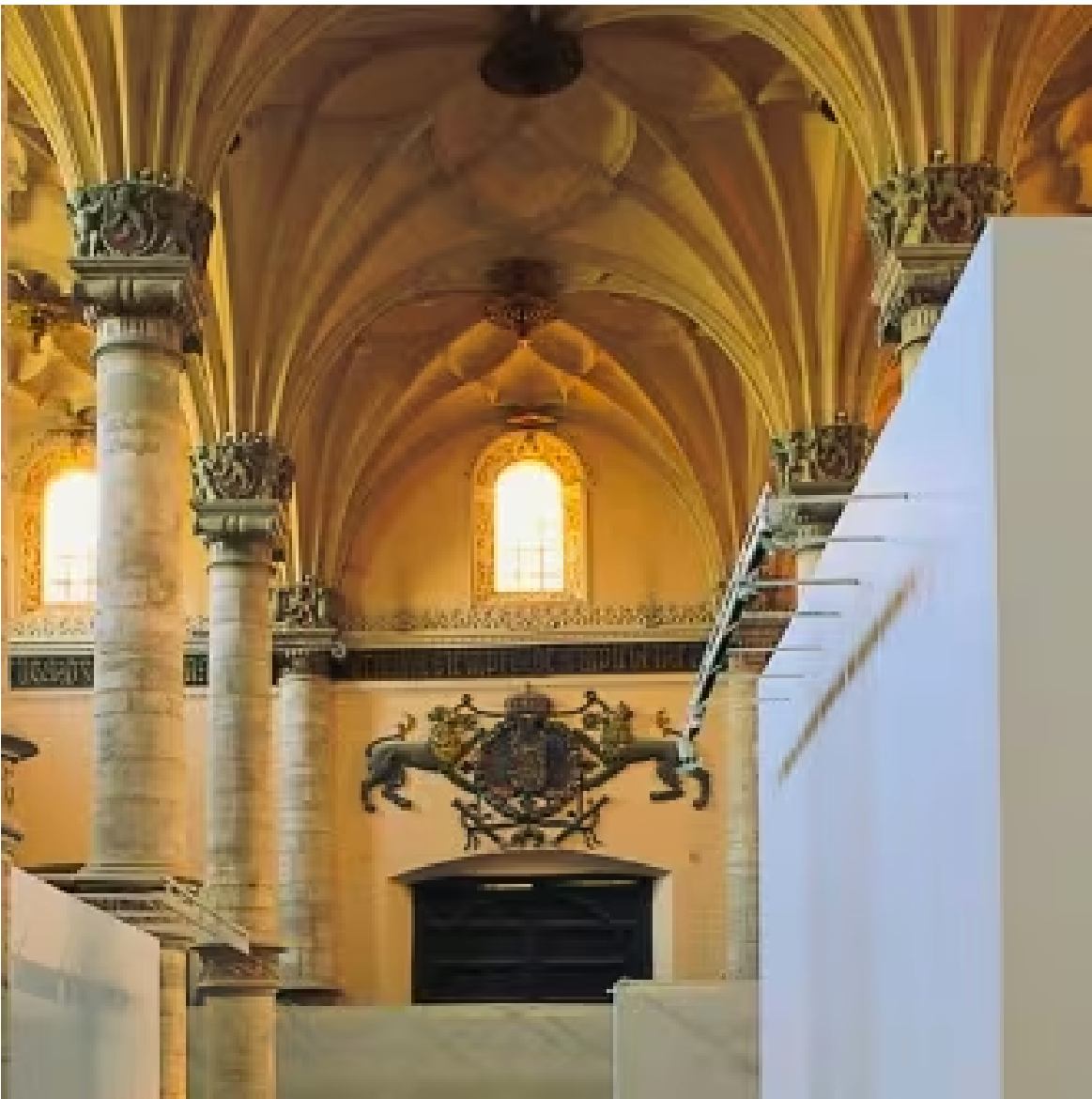
Saragosse, cathédrale de la Seo del Salvador; détail : supports et voûtement de brique enduite.
